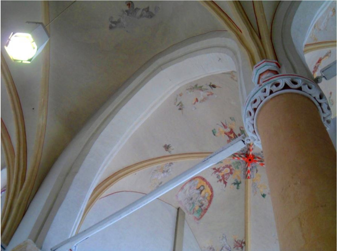
زولي، داخل كنيسة الدومينيكان القديمة المسماة Broerenkerk ، أثناء ترميمات عام 2012.
