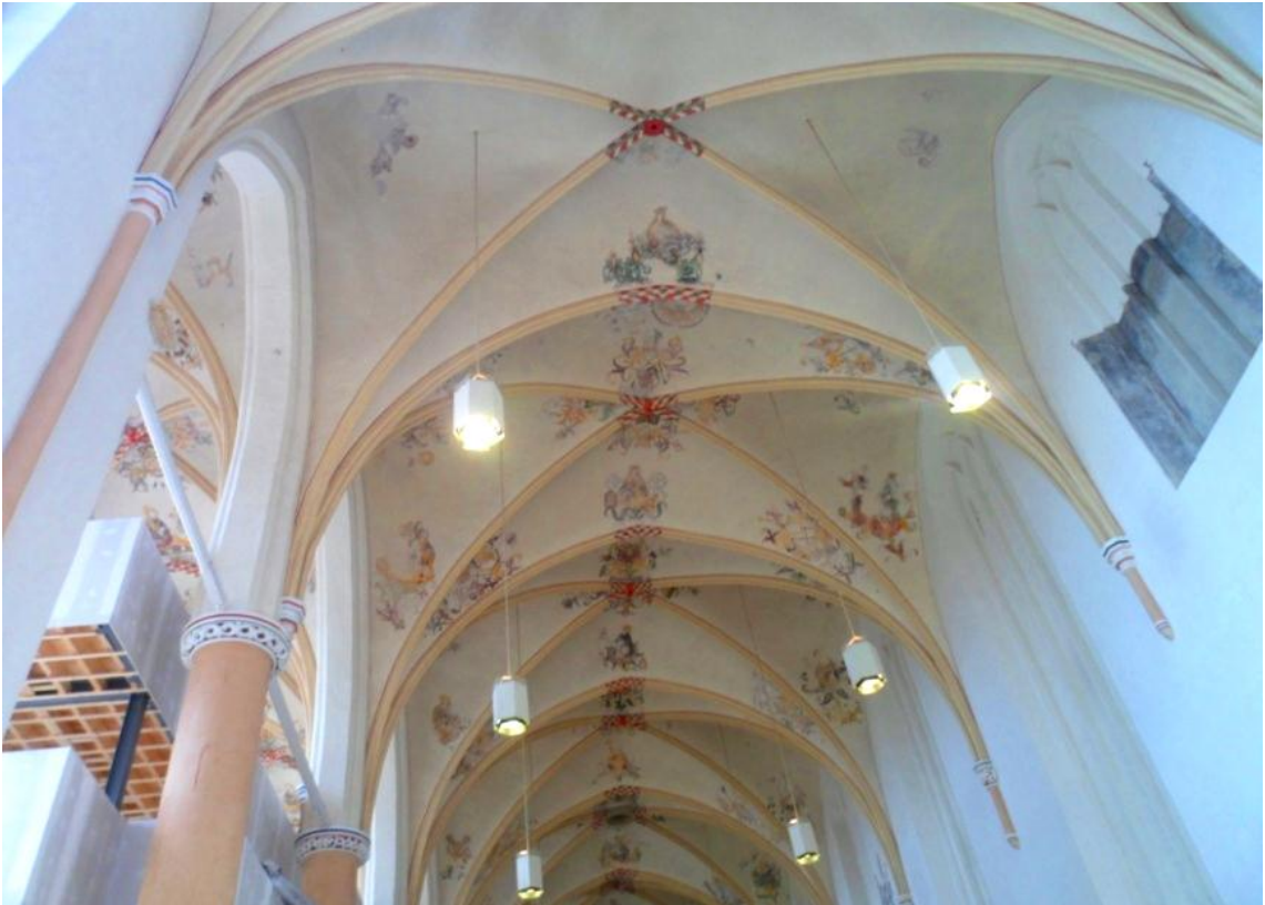
زولي، داخل كنيسة الدومينيكان القديمة المسماة Broerenkerk ، أثناء ترميمات عام 2012.
