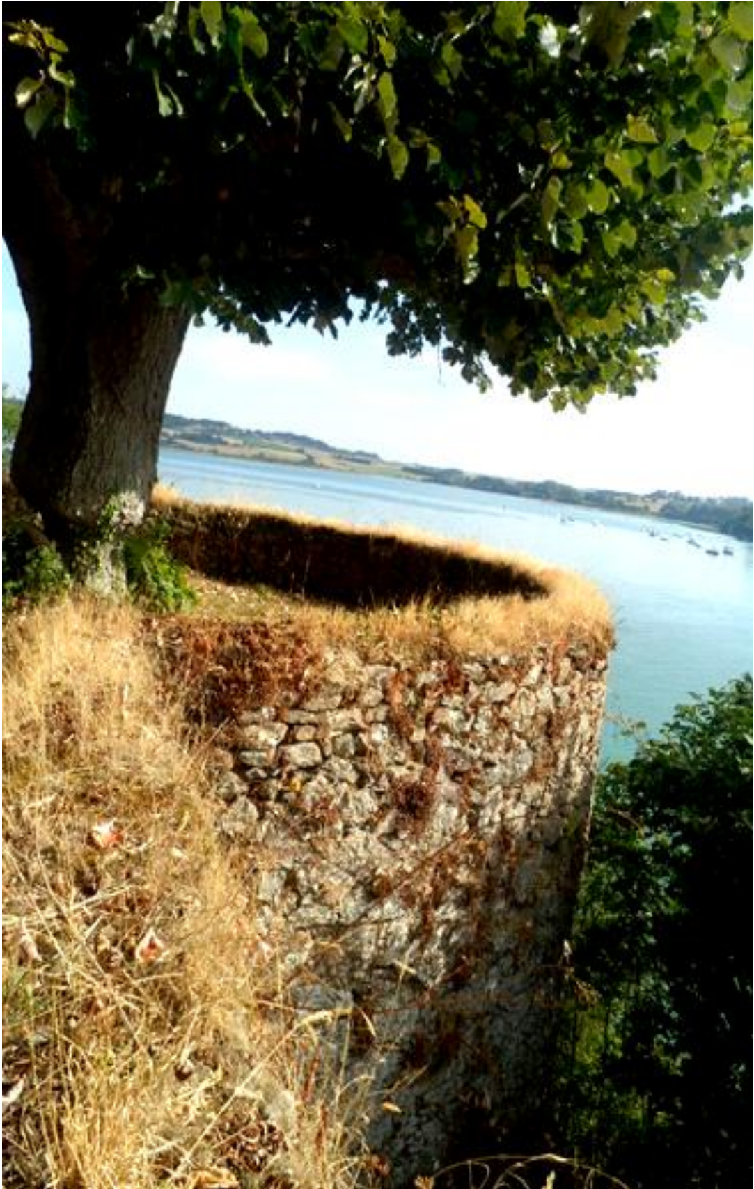
بلور على نهر رانس، الموقع الذي كان ينتصب فيه قصر ديلاروش: التحصينات القديمة لقصر ديلاروش.
